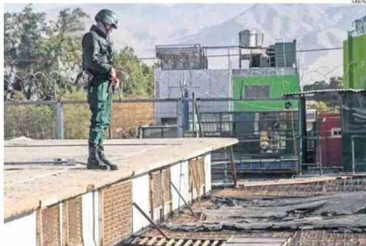
ACTUALMENTE EL MOP EJECUTA LA CONSULTORÍA DEL DISEÑO QUE CONCLUIRÁ EN SEPTIEMBRE DEL 2025.
