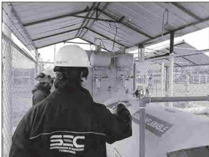
En distintos puntos de Villa Alemana, Limache y Quilpué se han desplegado equipos técnicos para monitorear los llamados de alerta por malos olores.
