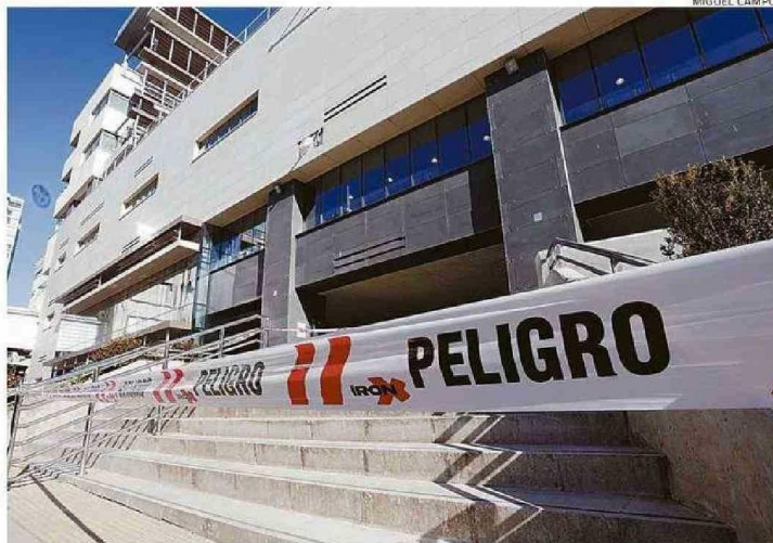
EL ACCESO PRINCIPAL DEL HOSPITAL ESTÁ CERRADO TRAS LA CAÍDA DE UNA PALMETA DEL FRONTIS.
