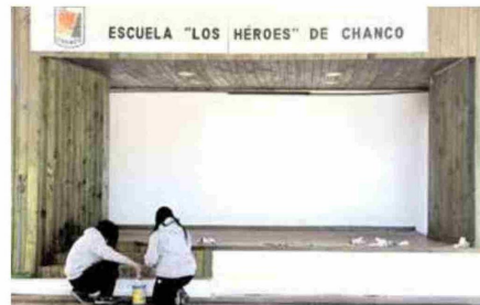
La Escuela "Los Héroes" fue uno de los colegios intervenidos en estos trabajos.
