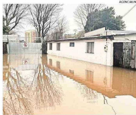
ESTOS 20 METROS DE CALLE LAS CAMELIAS QUEDARON BAJO EL AGUA.
