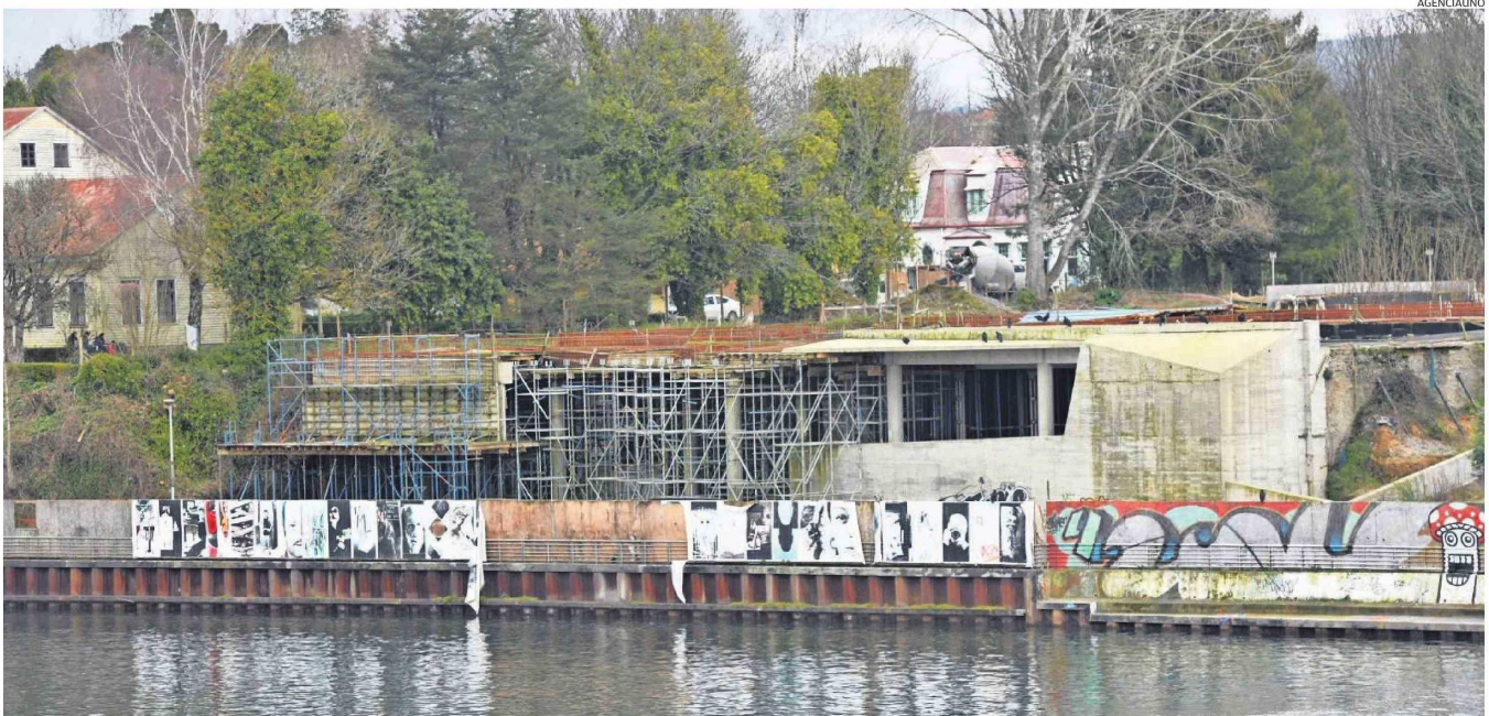
EN 2019 COMENZARON LAS OBRAS PARA LA RESTAURACIÓN Y AMPLIACIÓN DEL MUSEO DE ARTE CONTEMPORÁNEO DE LA UNIVERSIDAD AUSTRAL DE CHILE, EN LA CAPITAL DE LOS RÍOS.
