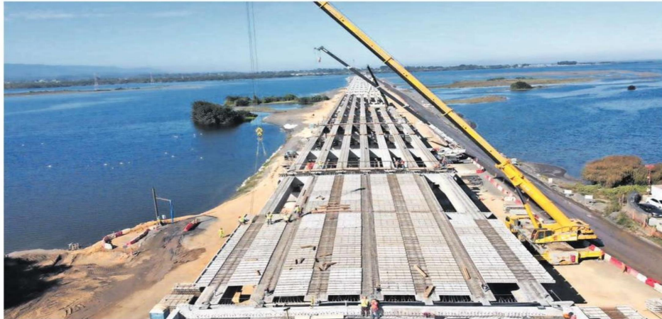
Según Obras Públicas, las faenas del puente Industrial presentan a la fecha más de un 40% de avance. Deben concluir en 2024.
