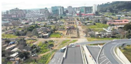
Los trabajos para la conexión del puente Bicentenario y Chacabuco consideran una inversión de $30 mil millones. Estarán listos en 2025.
