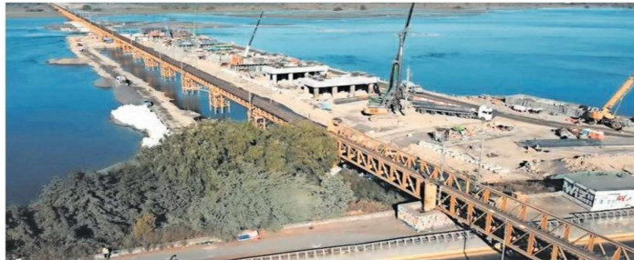
Un 10% de progreso tiene la construcción del nuevo puente Ferroviario. Entrará en operación en 2025.
