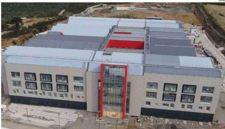
EL NUEVO HOSPITAL DE ANCUD SE LEVANTA EN EL SECTOR ALTO CARACOLÉS.
