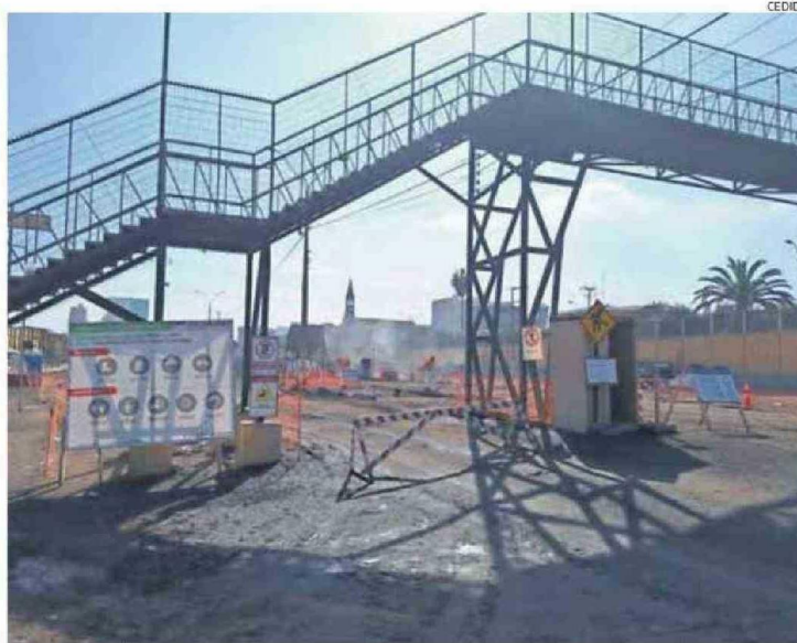
EN LA CARACTERÍSTICA PASARELA PEATONAL DEL SECTOR "PATIO BELLAVISTA SE IMPLEMENTARÁ UNA BARRERA.
