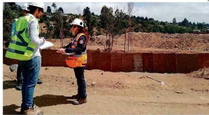
LA OBRA INCLUYE LA VARIANTE SAN JUAN, QUE CONECTARÁ LAS BRISAS CON BARRANCAS.
