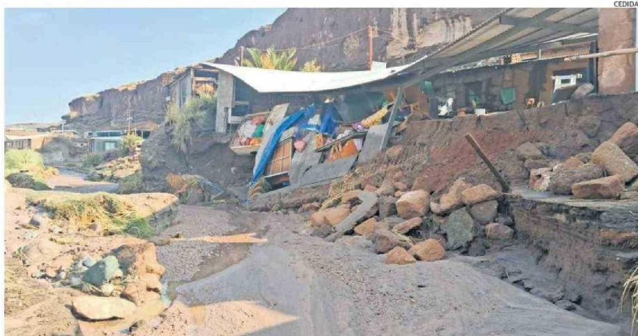
UNA DE LAS CASAS AFECTADAS POR LAS LLUVIAS Y EL DESBORDE DE LOS RÍOS EN EL PUEBLO DE CASPANA.
