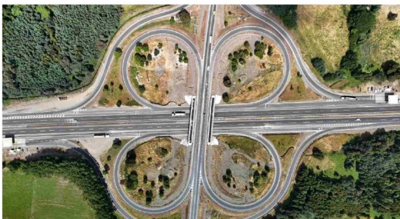
DURANTE EL 2025 SE LLEVARÁN a cabo las obras de la Ruta Nahuelbuta en su acceso a Los Ángeles.
