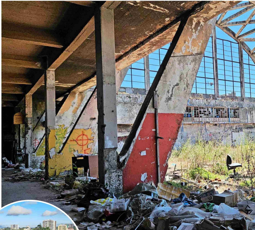
EL ESTADO ACTUAL DEL INTERIOR DE LA CÚPULA del Mercado Central de Concepción.
