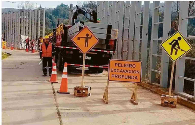
UN 11% DE AVANCE REGISTRAN LAS OBRAS CIVILES COMO CIERRE PERIMETRAL, ENTRE OTRAS.
