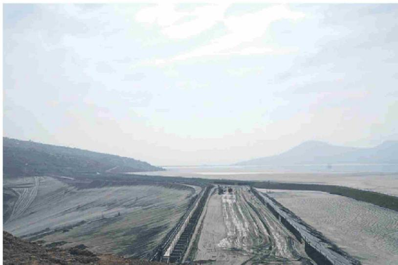
gruesa se utiliza en la construcción de los muros de contención de arenas, mientras que la fracción fina se va almacenando.
