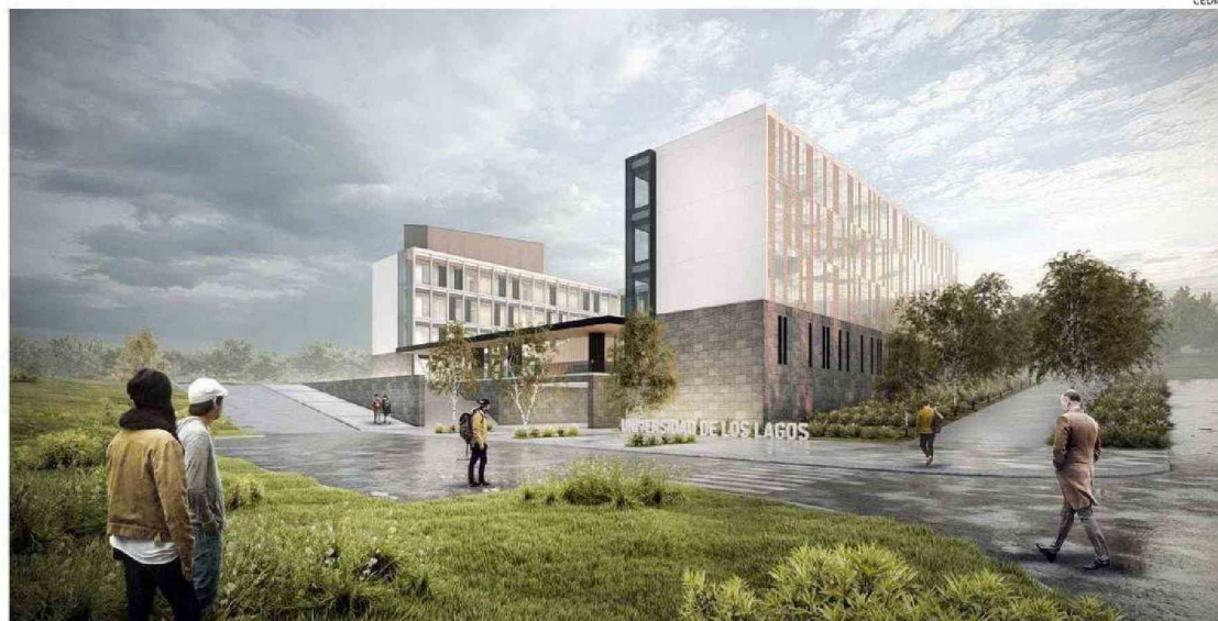
EL NUEVO CAMPUS SALUD, INGENIERÍA Y ARTES DE LA UL DE LOS LAGOS SIGNIFICARÁ UNA INFRAESTRUCTURA EDUCACIONAL DE 5.399 M2 DE CONSTRUCCIÓN, EMPLAZADA EN CHINQUIHUE.
