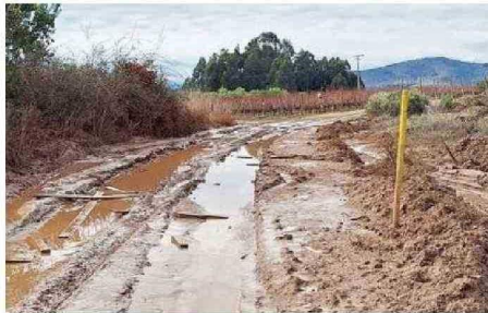
ASÍ QUEDÓ EL CAMINO VECINAL DESPUÉS DEL ÚLTIMO TEMPORAL.
