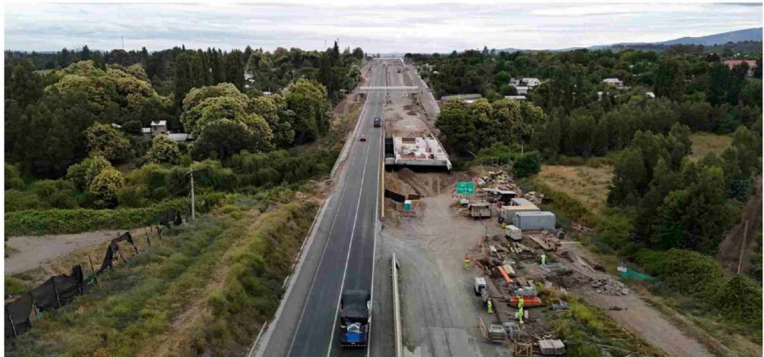
LA CONSTRUCCIÓN DE LA RUTA NAHUEL BUTA representa una inversión de 250 millones de dólares.
