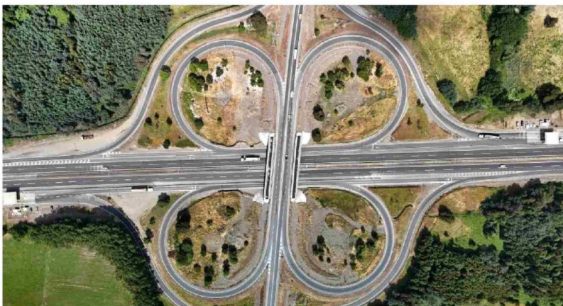
DURANTE EL 2025 SE LLEVARÁN a cabo las obras de la Ruta Nahuelbuta en su acceso a Los Ángeles.
