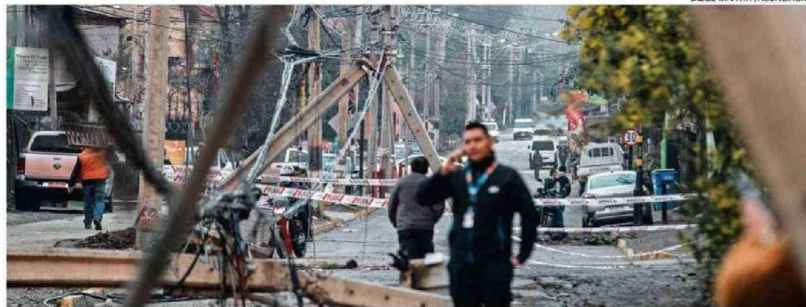
CUADRILLAS DE LAS COMPAÑÍAS ELÉCTRICAS, MUNICIPIOS Y LAS FUERZAS ARMADAS CONTINUABAN AYER EN TRABAJOS DE REPOSICIÓN DEL SERVICIO.
