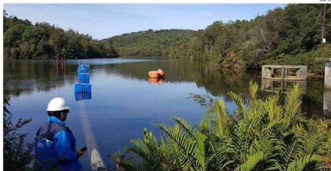
FISCALIZACIÓN DEL TRANQUE DE ABASTECIMIENTO DE AGUA EN PUDETO, EN ANCUD.
