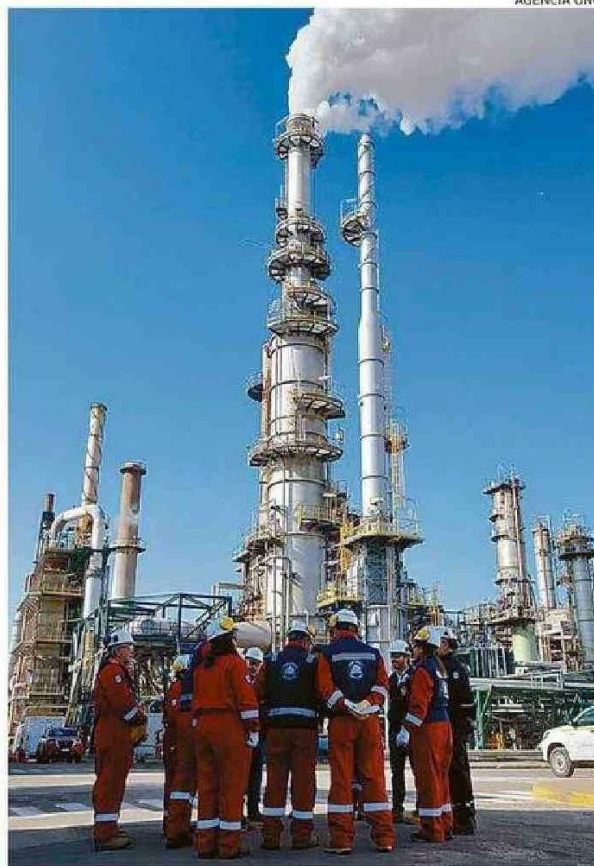
FUERON INSPECCIONADAS INSTALACIONES DE ENAP EN CONCÓN.
