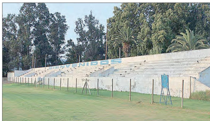
Así luce hoy el Estadio Cemento Melón, al final de la población Cemento y que ha permitido diversas actividades deportivas por más de seis décadas.
