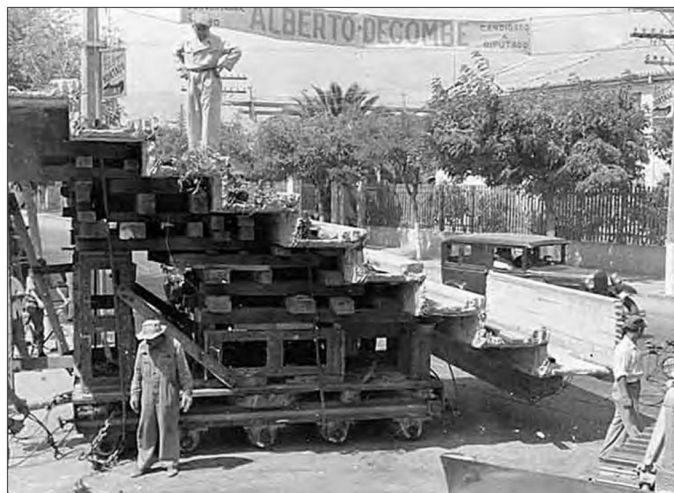
Un verdadero hito y una obra de ingeniería para la época fue cortar y cambiar de lugar las tribunas del recinto deportivo. (Foto: Emilio Miranda)
