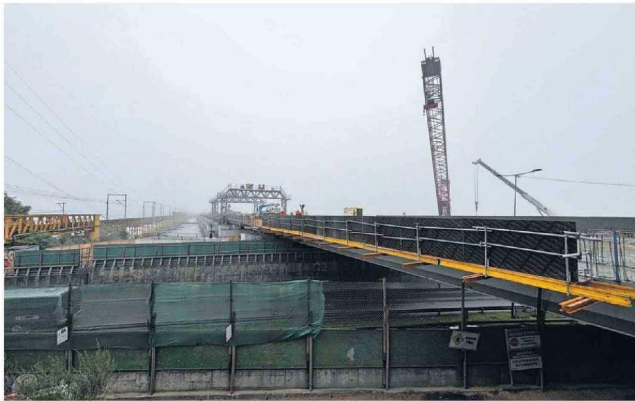
El puente Ferroviario es una de las obras de infraestructura más esperadas de la Región del Biobío.
