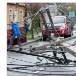
Un tornado voló techos y derribó árboles y postes en Penco.
