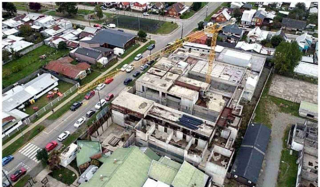
LOS TRABAJOS SE RETOMARÁN EN CALLE CRISTINO WINKLER.
