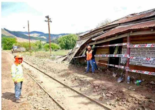
La Estación de Corinto captada para la puesta en marcha del Ramal Talca-Constitución en 2023.
