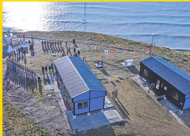
Las instalaciones argentinas de la discordia en Tierra del Fuego. / ARA
