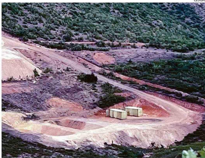
SE ESTÁN DESARROLLANDO TRABAJOS Y PREOCUPA INSTALACIÓN DE PLANTA.
