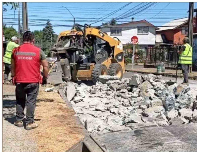
Zona residencial. En la pequeña calle Mónaco, situada en el sector Regional, también fue necesario efectuar reparaciones.
