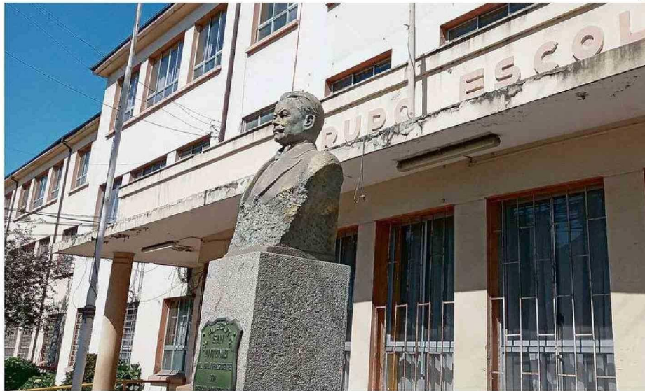
LA DAEM ESPERA INVERTIR EN LA REPARACIÓN DE LA TECHUMBRE DEL GRUPO ESCOLAR.
