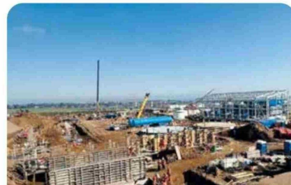
En funcionamiento, la planta multipropósito generará mil litros de agua desalada por segundo.
