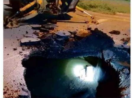
EL AGUA CAUSÓ LA EROSIÓN BAJO LA SUPERFICIE DEL ASFALTO.
