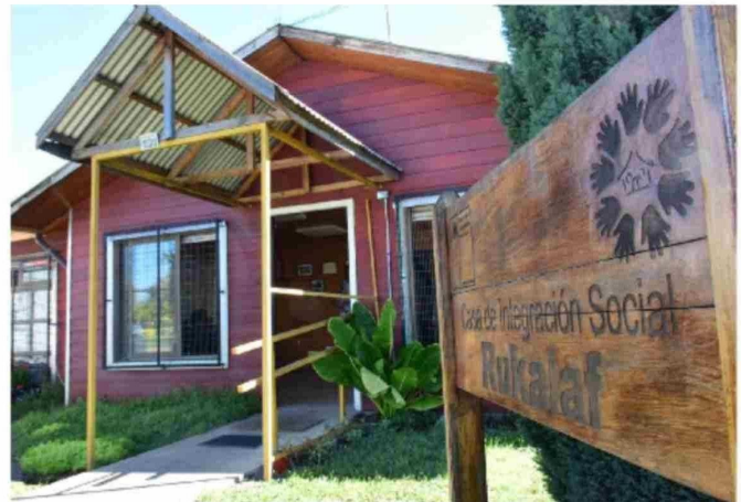
LAS NUEVAS INSTALACIONES contemplaron la construcción de un nuevo espacio de 82.77 metros cuadrados.
