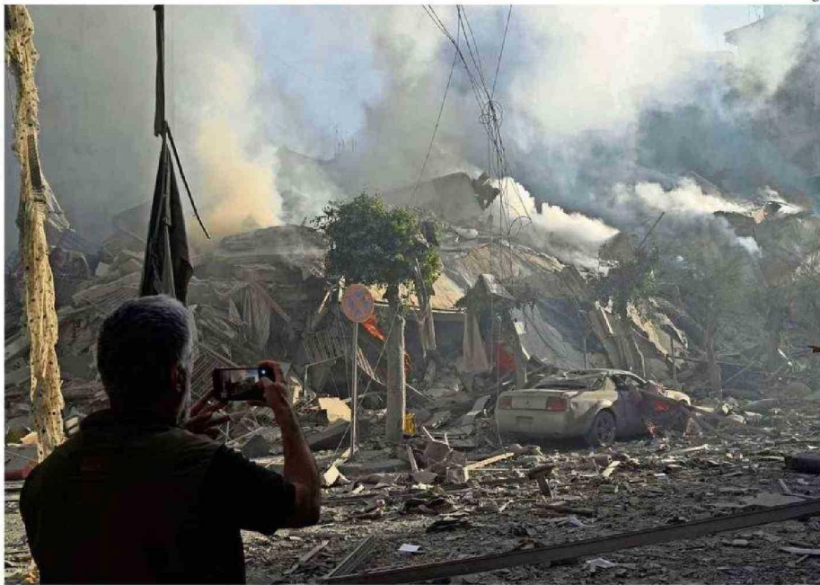
UN HOMBRE FOTOGRAFÍA UN EDIFICIO TRAS UN ATAQUE AÉREO ISRAELÍ SOBRE EL BARRIO DE DAHIEH, UNO DE LOS BASTIONES DE HEZBOLÁ, EN BEIRUT.
