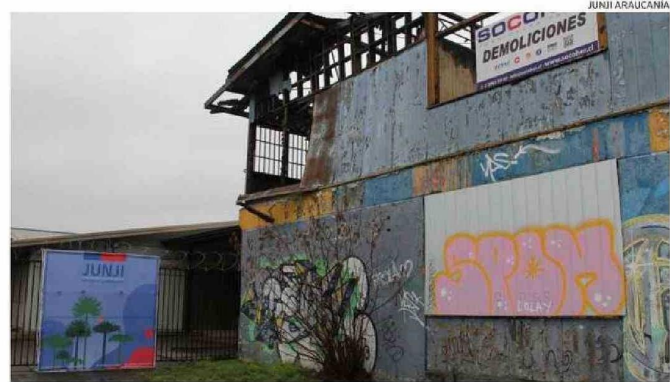
COMENZÓ EL PROCESO DE DEMOLICIÓN DE LA EXESCUELA TURINGIA DE TEMUCO.
