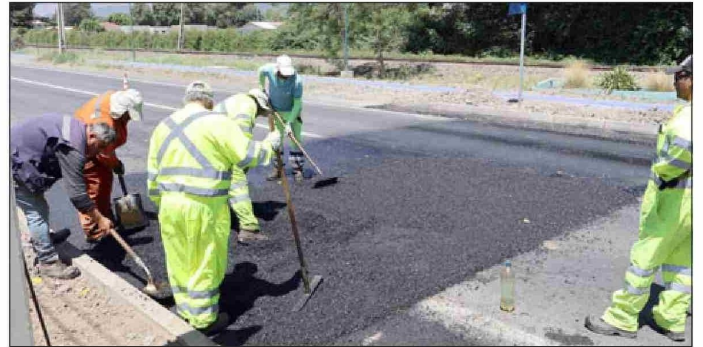
Diversas obras de seguridad vial se ejecutan en Panquehue.
