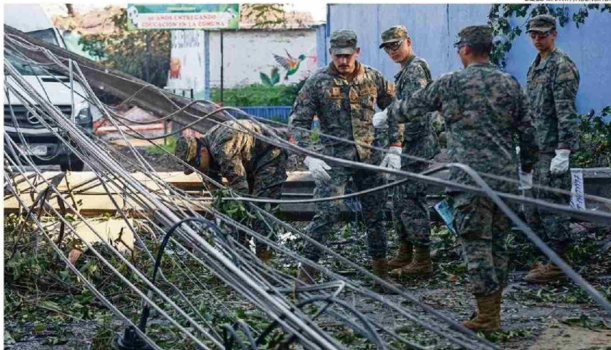
PERSONAL DEL EJÉRCITO SE UNIÓ AYER A LOS TRABAJOS DE LOS MUNICIPIOS Y LAS EMPRESAS PARA RESTABLECER LA ENERGÍA ELÉCTRICA.
