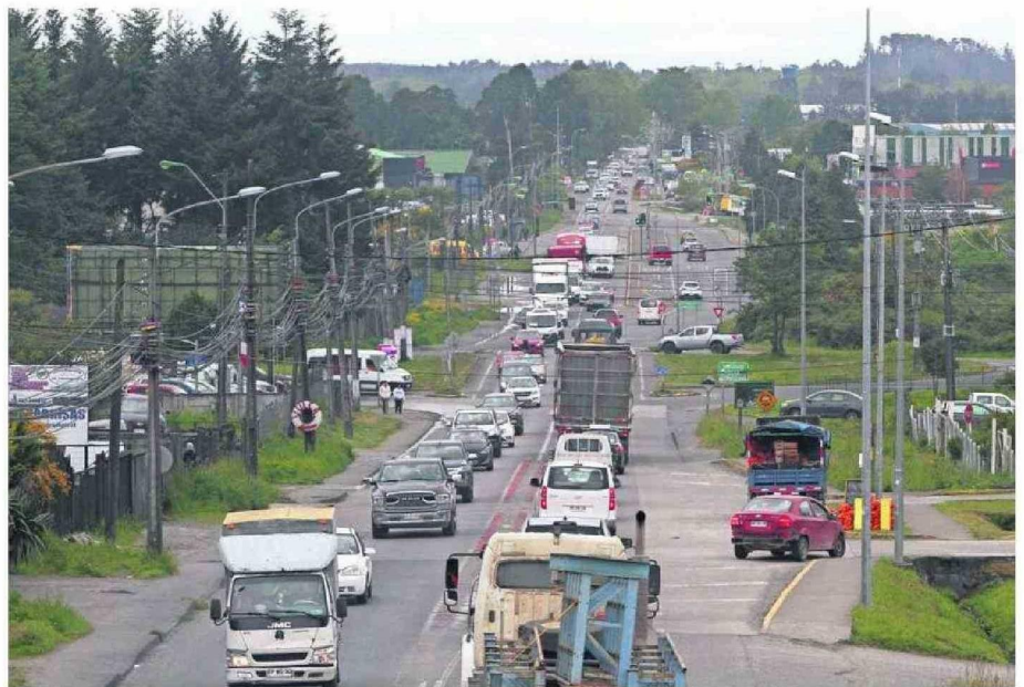
LA CONSTRUCCIÓN DE LA DOBLE VÍA AL AEROPUERTO EL TEPUAL CONSTITUYE UNA DE LAS PRIORIDADES PARA EL PRÓXIMO AÑO.
