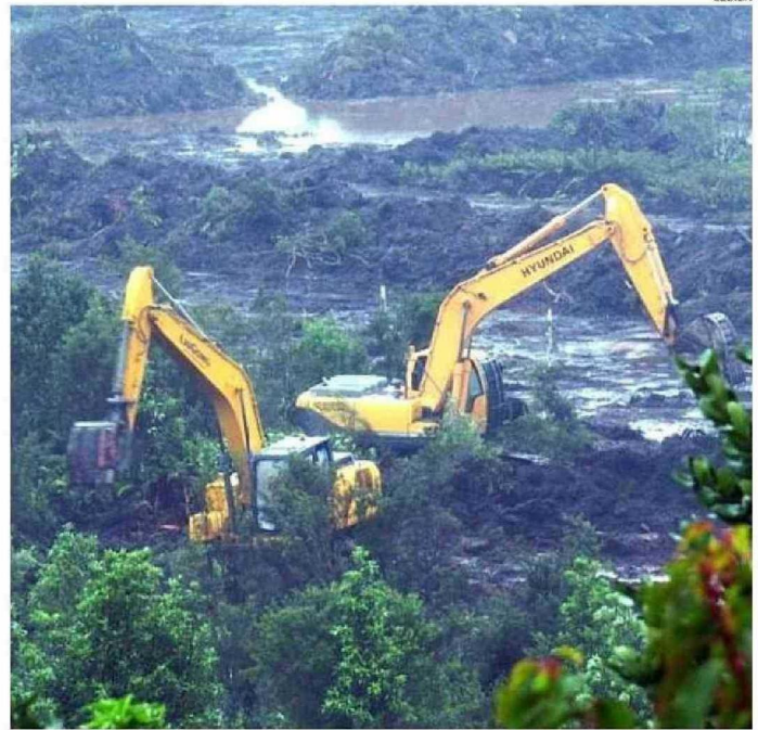
LA MAQUINARIA PESADA CAPTADA REALIZANDO FAENAS HACE DÍAS.
