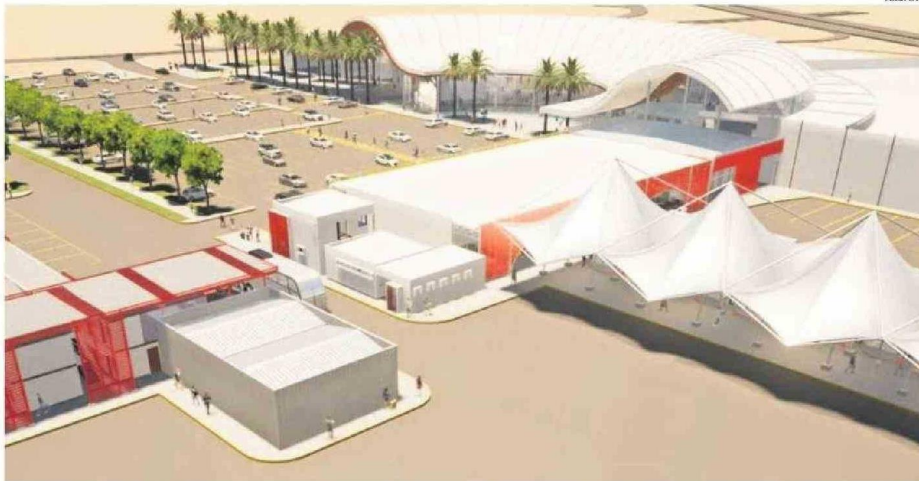
A PRINCIPIO DE ESTE MES SE INICIARON LAS OBRAS PARA HABILITAR EL ACCESO A LAS INSTALACIONES DEL TERMINAL RODOVIARIO DE CALAMA.
