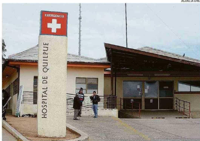
EL PASADO 13 DE NOVIEMBRE LA MADRE INGRESÓ AL HOSPITAL DE QUILPUÉ.
