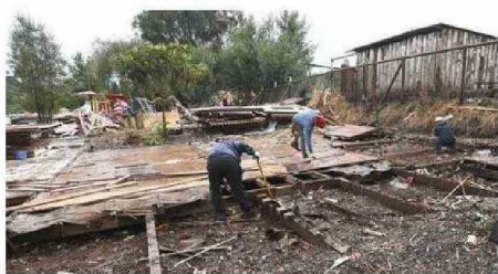
LAS OBRAS DE DESARME DE LA ANTIGUA ESCUELA.
