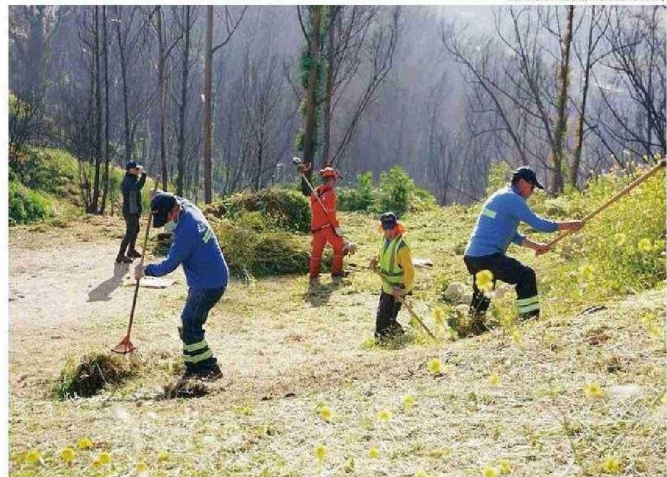
PARA DICIEMBRE SE ESPERA TENER LISTO LA MANTENCIÓN DE LOS CORTAFUEGOS Y SE TRABAJA EN DESMALEZADO.
