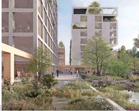
El proyecto Distrito de Innovación ID3 pretende transformarse en el principal nodo urbano de innovación de la Región del Biobío, ubicado en un área geográfica altamente conectada con la ciudad y la comunidad.
