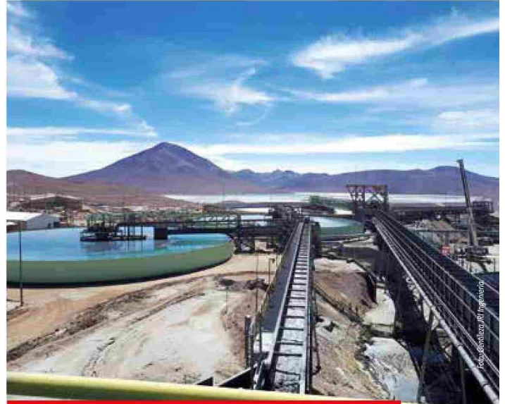
Foto: Centilera JRI Ingeniería.
