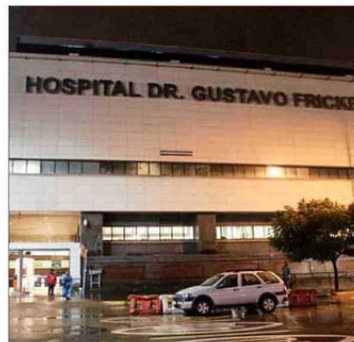
El Gustavo Fricke fue uno de los hospitales de Valparaíso con filtraciones.
