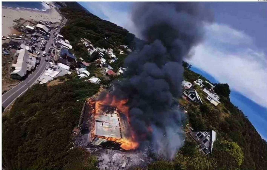
EL FUEGO COMENZÓ EN UNA VIVIENDA Y EL VIENTO PROPAGÓ LAS LLAMAS A LAS OTRAS CONSTRUCCIONES, RESULTANDO CUATRO AFECTADAS.
