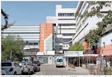
IMPLEMENTACIÓN. —A raíz del incendio de 2021 en el Hospital San Borja Arriarán, en Santiago, se instalaron módulos de atención.
