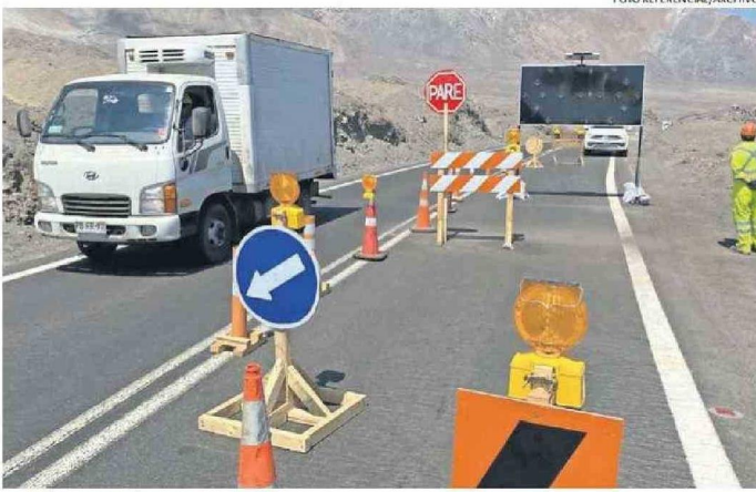
ESTA MEDIDA SE DESARROLLARÁ POR TRABAJOS CON TRONADURAS EN ESTE SECTOR.
