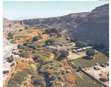
EN EL VALLE DE LASANA TAMBIÉN SE LOGRÓ EL EMPALME ELÉCTRICO.
