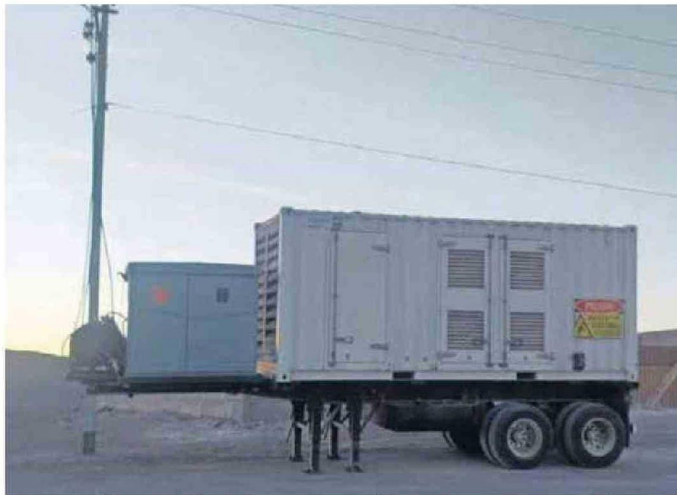
AYER POR LA MAÑANA SE LOGRÓ INSTALAR EL GENERADOR ELÉCTRICO A LA ESPERA DE LA REPOSICIÓN TOTAL.
